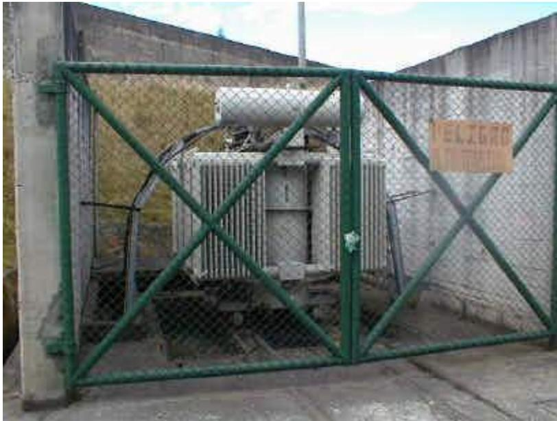
Figura 5. Transformador de patio, Estación San Vicente
